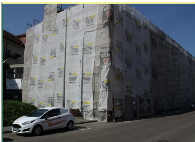
A felújítás alatt álló teljesen beburkolt Csiky utcai épület
